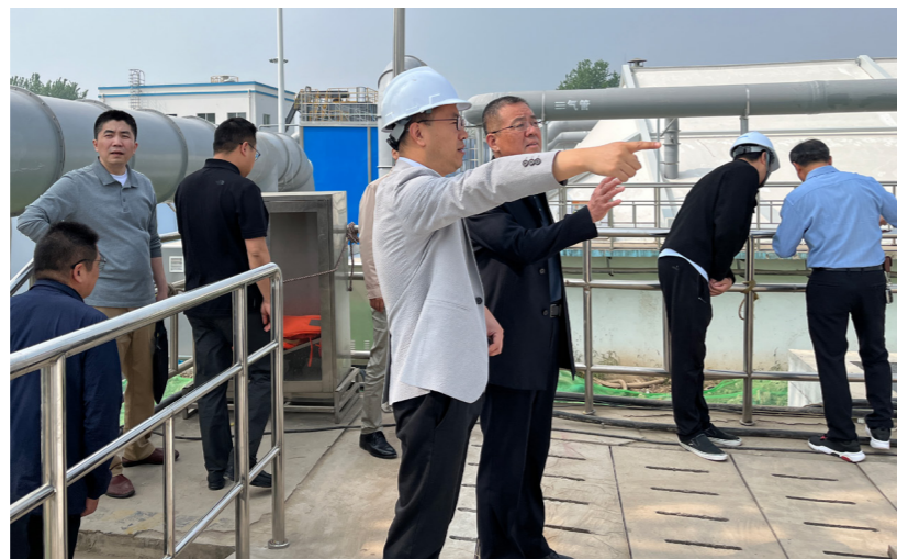
浦口区人大常委会调研珠江污水处理厂环保设施运行情况。
